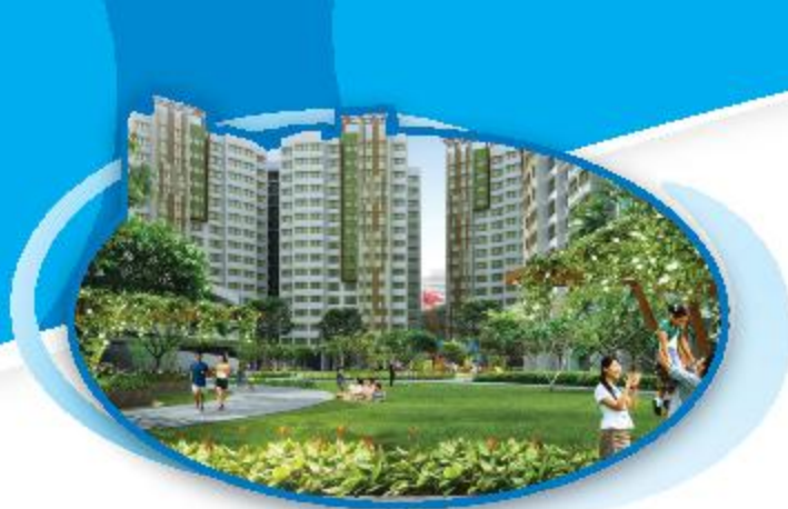
▲ New Housing - Boon Lay Meadow 新的住宅项目 - Boon Lay Meadow
